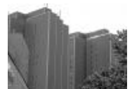
Hochhäuser am „Eastgate“
